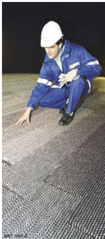
Проверка насадки после монтажа
