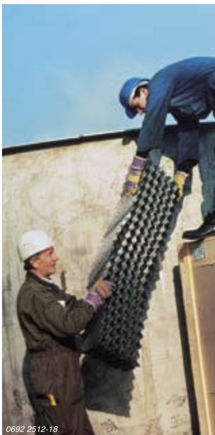
Модернизация вакуумной колонны с применением насадки Mellapak
