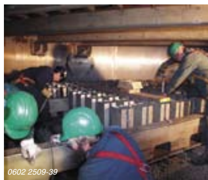
Установка распределителя жидкости
