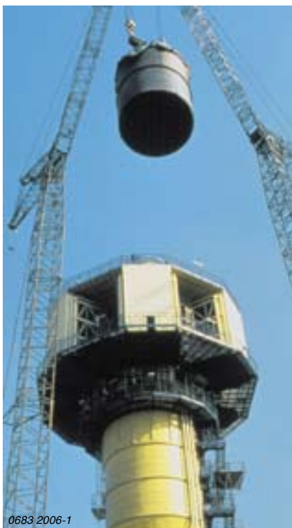
Внутренняя обечайка опускается в колонну с помощью двух кранов. Масса: 100 тонн
