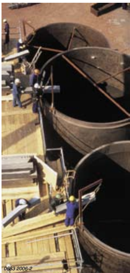
Насадка устанавливается внутри корпуса колонны с заранее смонтированных площадок
